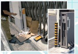
床の塗装を剝がし、洗浄→ひび割れ補修工事後、 ブルーグレーに塗装しました。工程が多いため日 を分けて作業を進めましたが、季節柄雨での延期 も多く苦労しました。土日に作業をするので、休 み前は車を粉体事業所へ移動するなど社内一丸と なって協力しました。
